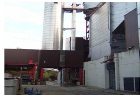
图 1.垃圾焚化站 60 英尺（18.5 米）高的燃烧盐仓
